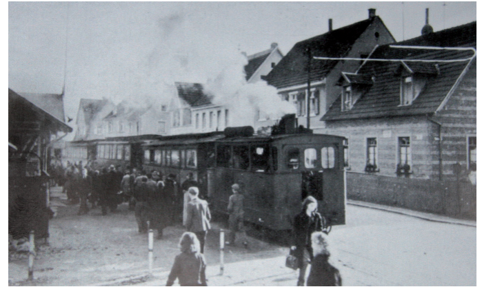
OEG Bahnhof Dossenheim
